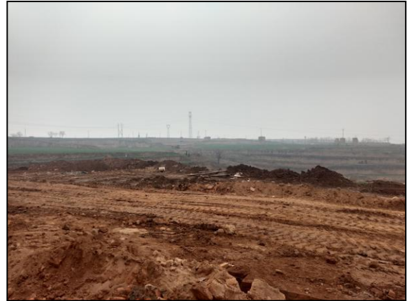
照片 1.3-2 新建矿山道路
